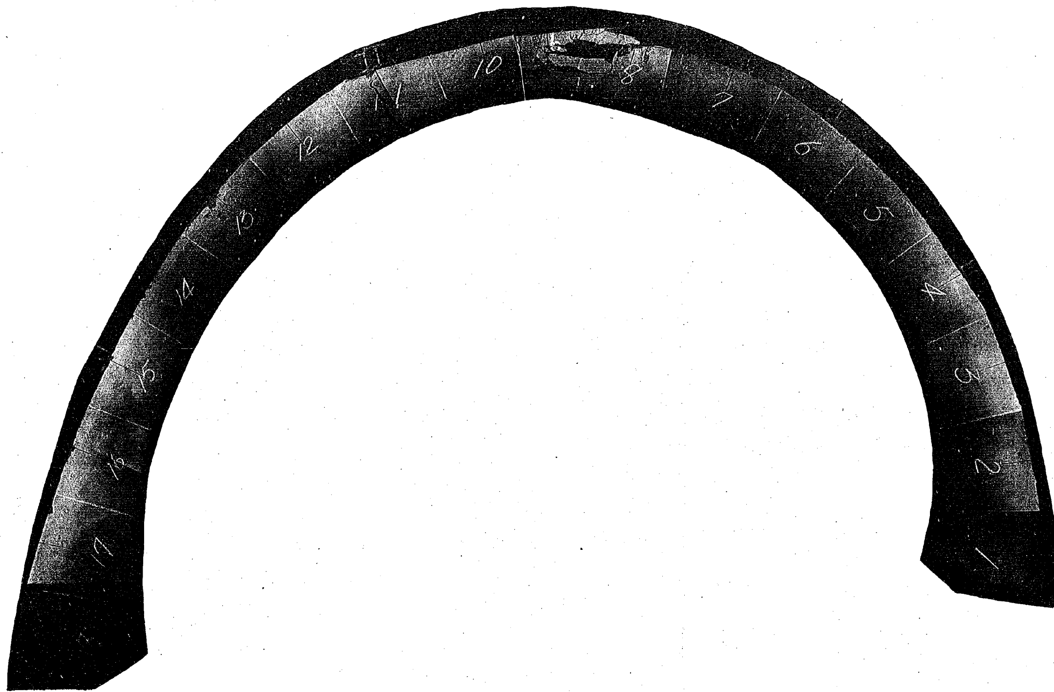
破壞狀況写真
