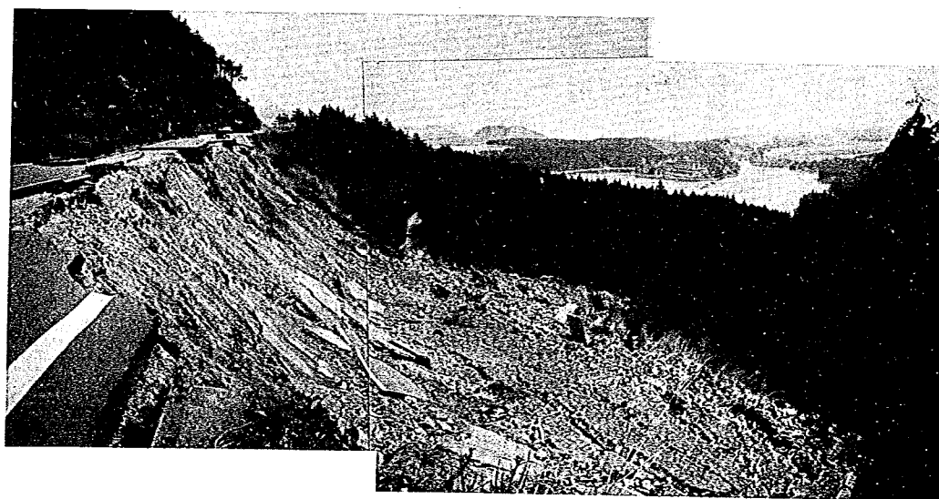
写真 - 6 別府 - 阿蘇有料道路の崩壊（山下池付近）
