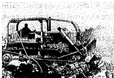
写真3.1 ROPSを装備して作業中のブルドーザ
