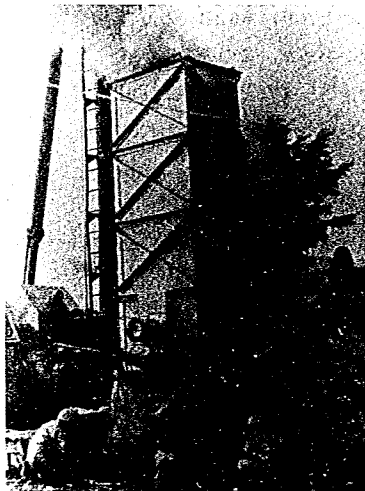
写真5-1-3 MDパイル工法
