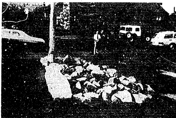
b. 格子排水口で低地面に雨水を貯留するように造られた事務所用駐車場（コロラド州ボールダー）
