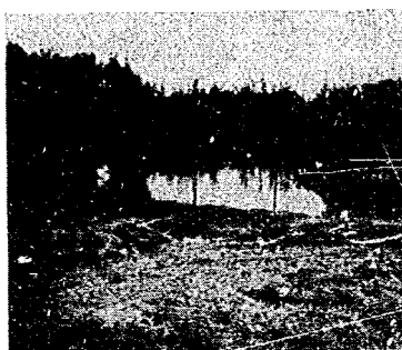
a 洪水，土砂制御用の 暫定貯留池
