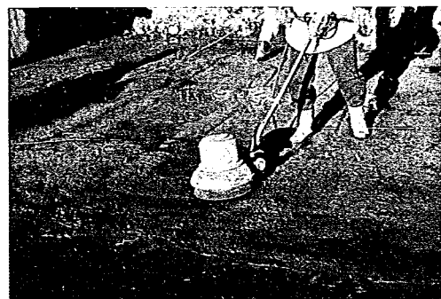
写真4 打継目のポリッシャかけ
