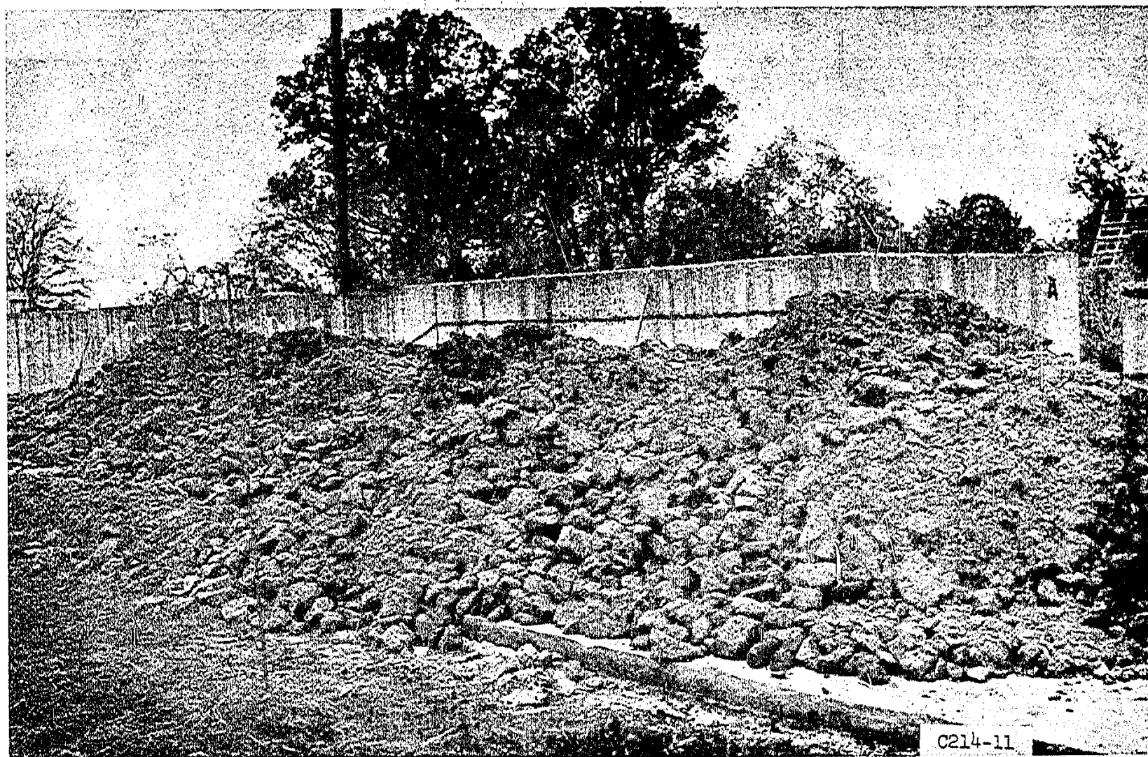
図-3 先行基礎コンクリート
