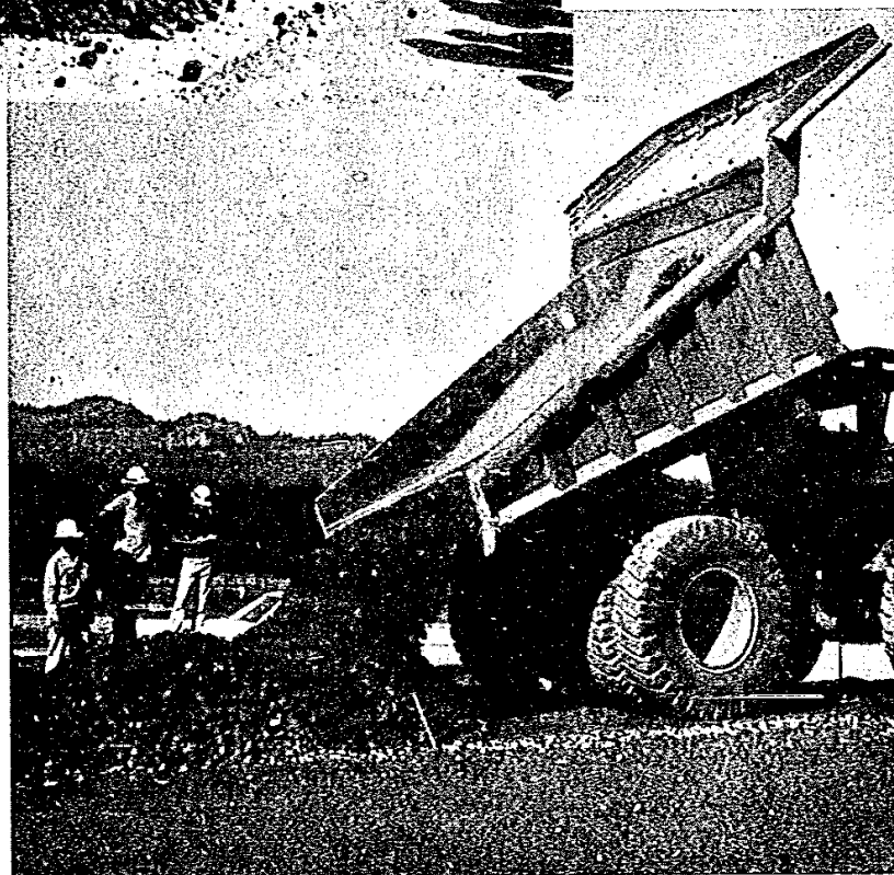
写真-2 ダンプ状況
