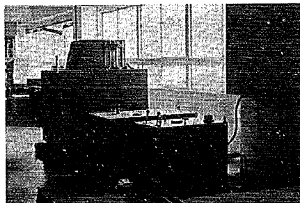
写真-3 油圧発生装置
