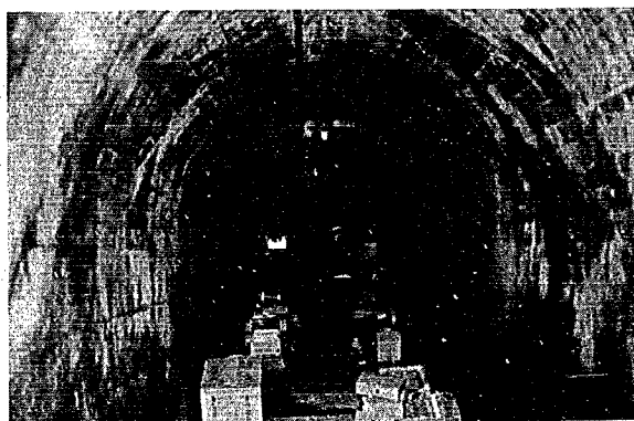
写真-19 小仏トンネル実験状況
