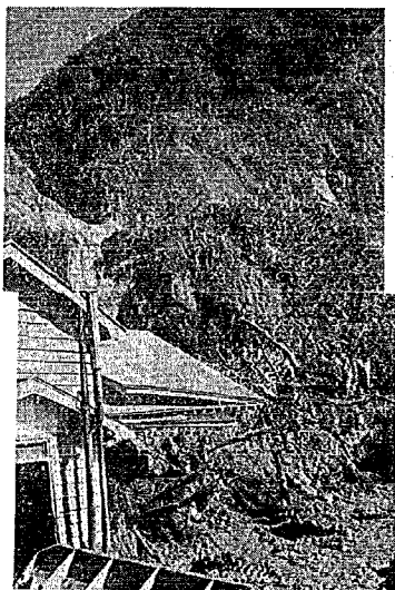
写真-11 強風化岩の滑落 (温泉余土) 5-(2)-b (北海道)
