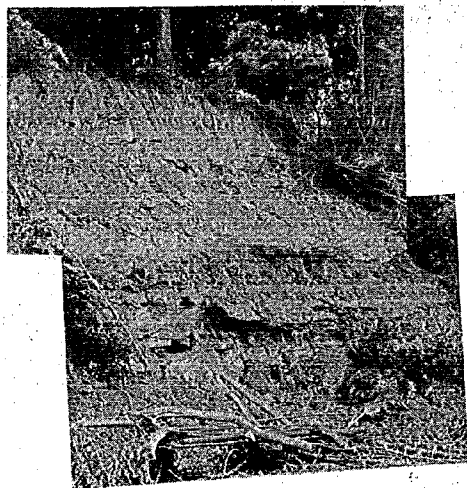
写真-15 岩(II)の崩落（互層）7-(1)-a（千葉）
