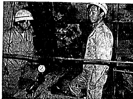
写-3 引抜き試験の状況
