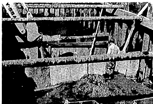
写真-3 中央部（深掘り部）の掘削
