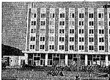
写真-7 八丈島国際観光ホテルの被害
