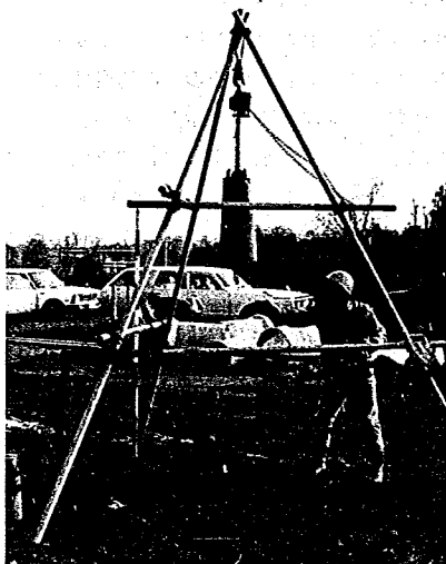
写真2 重錘落下 (150kg, 2mの高さより自由落下)
