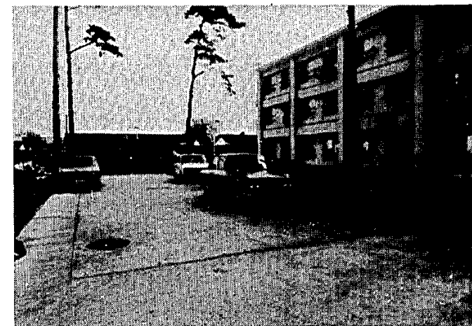
写真-68 東京都空堀川流域、東京国税局 東村山独身寮、地下貯水槽 (180m 3 )
