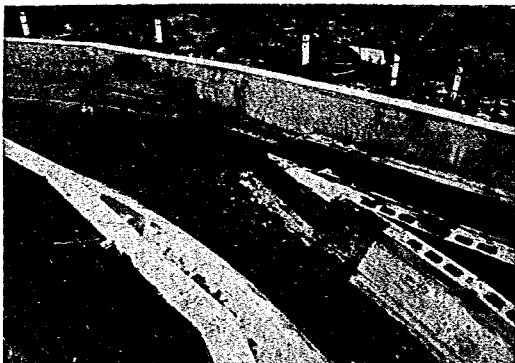
写真-13-2 分流点, 分流壁への 対策工
