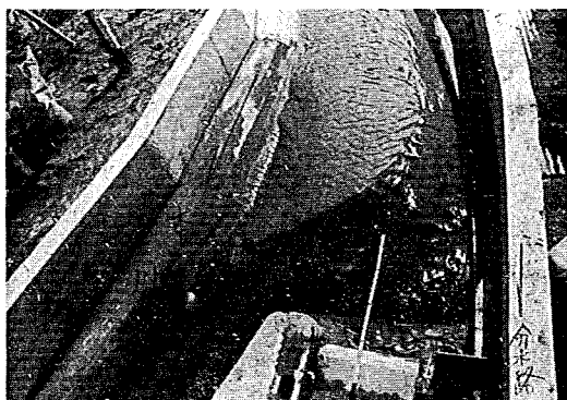
写真 6-3 分流点護床工設置，通水後
