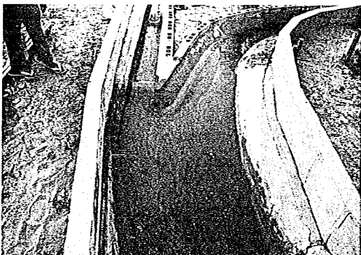
写真-12-5 分流点，分流壁形状の 検討；通水後
