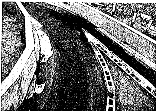
写真-12-9 分流点，分流壁形状の 検討；通水後
