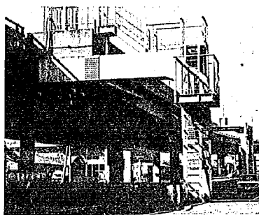
写真-1.6 首都高速道路・羽田線品川埠 頭付近の非常梯子
