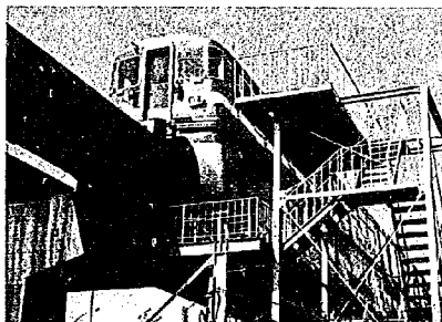
写真-1.2 品川埠頭近くの非常用ホーム
