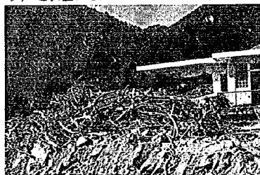
写真-6 土石流による被害 コンクリートの家も破壊する 赤坂川(香川県池田町)
