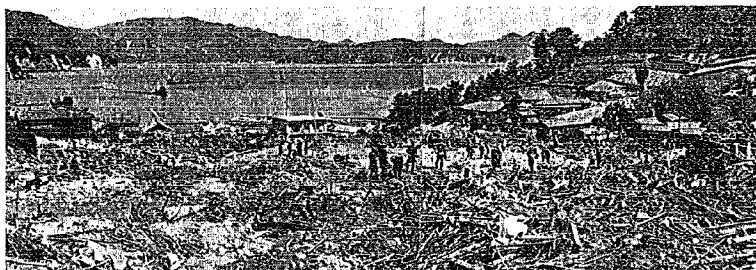
写真-7 土石流による被害 最も人的被害の多かった谷尻地区（香川県池田町）
