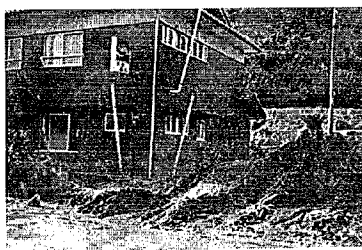
写真-10 掃流形態による被害 土砂の堆積地、土砂は2 m近く堆積しているがガラス1枚こわれていない。 琴塚川（香川県土庄町）
