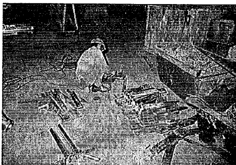
写真・付録-8 仕 上 げ
