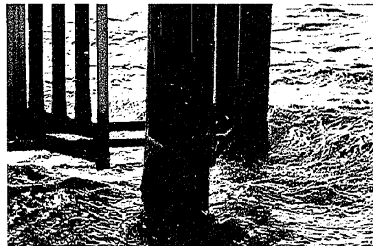
図 4, 4' アルミ溶射+厚膜型タールエポキシ
