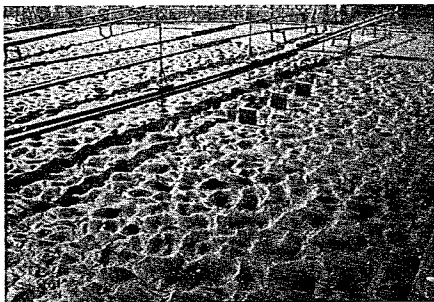
写真-4.4 出水後の水叩周辺の河床状況
