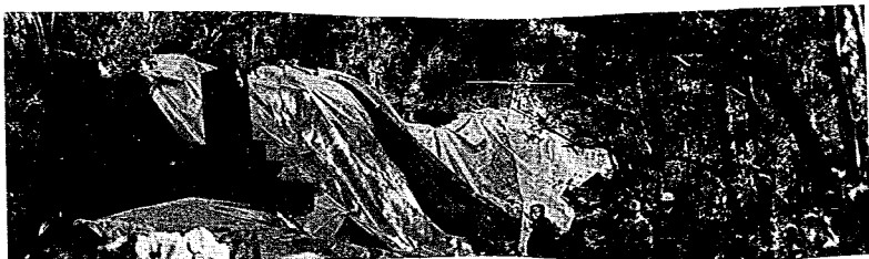
写真-2 布師田地すべり滑落崖附近
