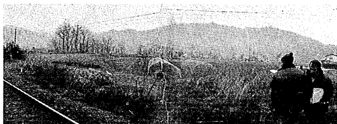
図-41 松川扇状地上の段差
