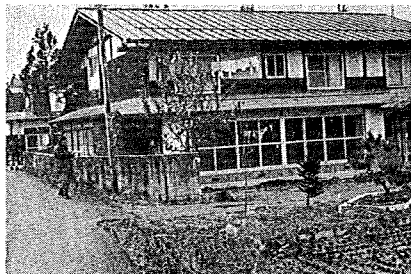
図-38 流水の流下してくる向きにコンクリートの壁をもうけている。
