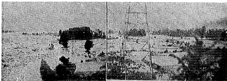
図-31 昭和34年災害状況(№15付近よりの氾濫状況)
