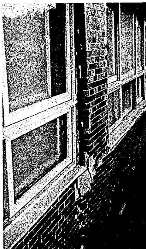
写真-27 釧路町釧路温泉の三恵病院 の被害
