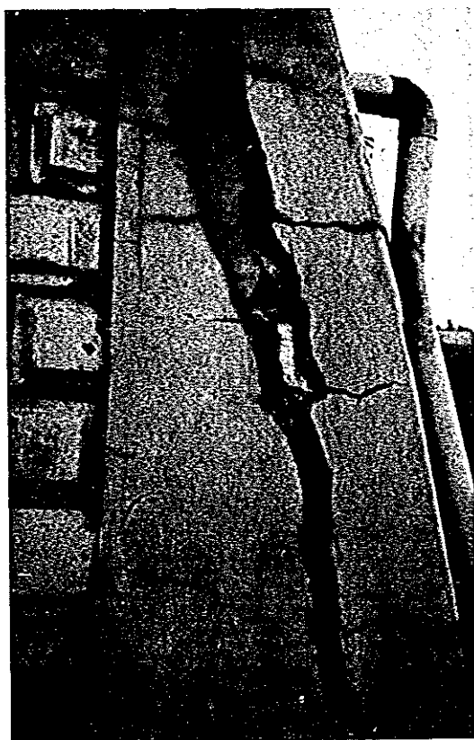
写真-30 警別町警別温泉の三恵病院の被害
