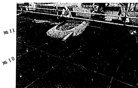
実験 IV-1 ~ 20hr 後実験後放水路付近
