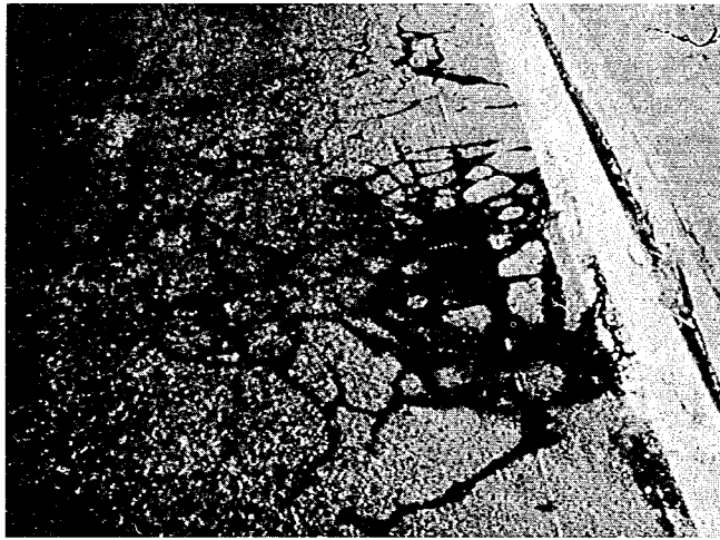
図—17 舗装端部の損傷
