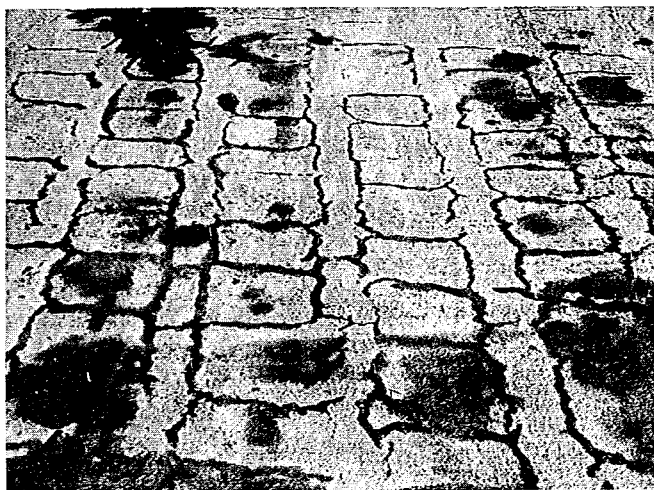
図一13 摩耗した表面のひびわれ形態
