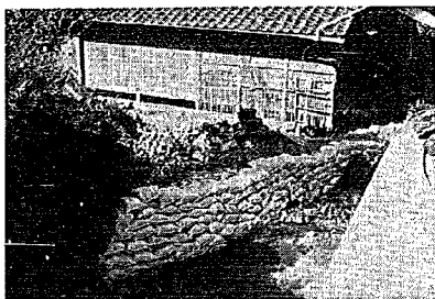
写真-9 梨木川における被害の状況
