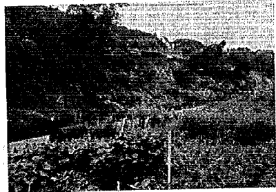
写真-4・3 道路切取法面のくずれ
