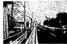
国道1号線 原宿付近
