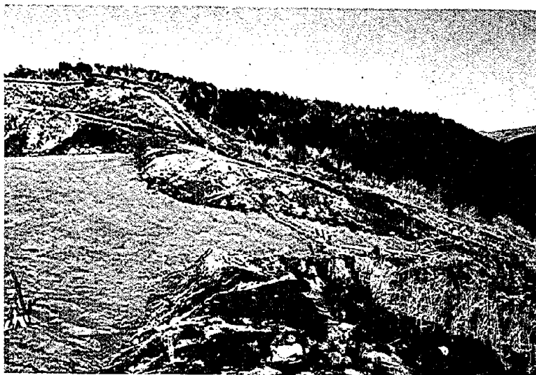
写真3 スライム貯留用堰堤の崩壊によるスライムの流出 (天城湯ヶ島町持越地区, 2月15日撮影)
