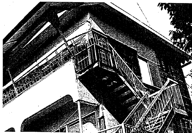
写真6 住家の振動による被害 (下田市白浜地区, 1月19日下田市役所撮影)
