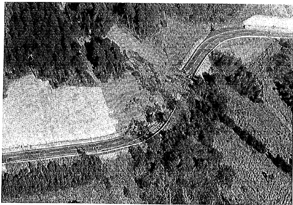
写真 5 - 16 ㊤ 修善寺—下田線 大町茶屋下 下田側〔静岡県下田土木事務所による〕
