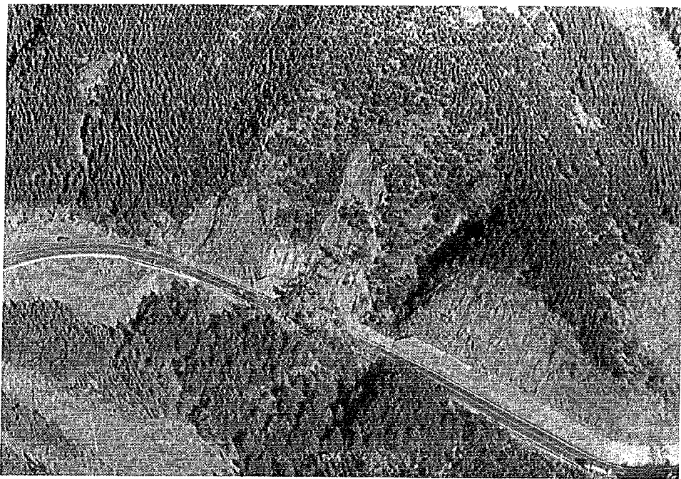
写真 5 - 15 ㊤ 修善寺下田線 七滝停付近より500m天城より 崩壊状況〔静岡県下田土木事務所による〕
