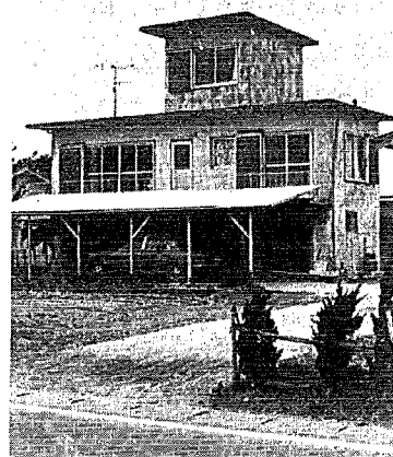
写真-2～3 伊勢湾台風後に鍋田干拓に作られたゲタバキ住宅 階下は駐車場，作業場，2階が居住部分に利用され，3階は物置兼避難所である。 しかし日常生活に対しては，不便が多く，評判は必ずしもよくない。やはり，人工 地盤とか，集合住宅の形での実現が好しかろう。
