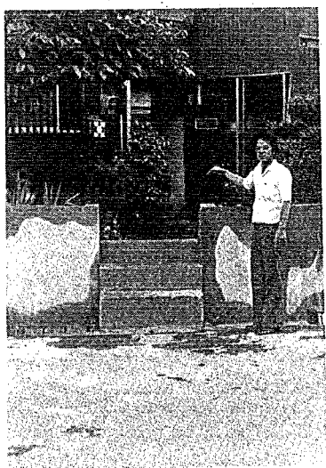
写真-10 塀による耐水化
