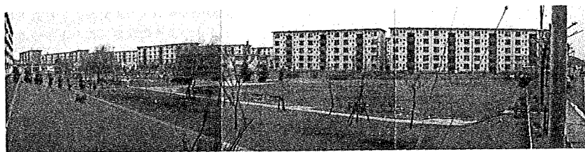
写真-1 新座団地の棟間貯留
