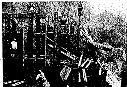
写真-5 河津町梨本地区県道の被害
