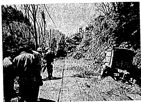
写真-2 田野一庄内線の切土面の崩壊
