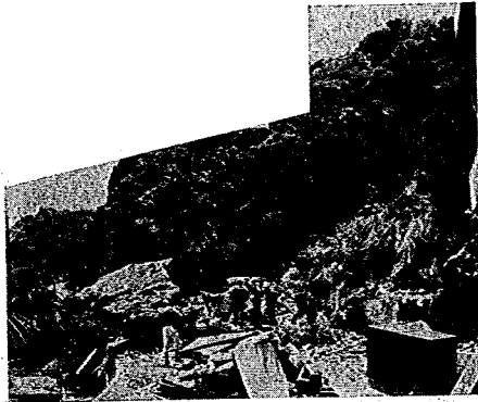
写真-7 岩塊の崩壊（石廊崎付近）
