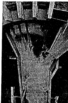
写真-13-1 減勢池の流況 (シュート・放水管同時放流) ゲート全開
