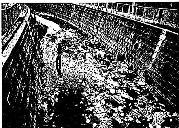
写真-14 妙正寺川新栄橋付近
