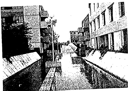
写真-4.5 ルーアン近郊の新都市 ル・ボードロイユ 集合住宅の地上1階部分を連絡する歩行者道 路網で、写真中央の勾配のついている部分は下 の車道を横断する歩道橋である。。
