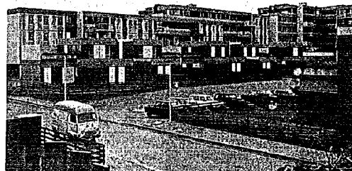
写真-1.18 ボードロイユ 集合住宅の裏側で、数種のタイプがあるが、 これは小庭を設置したものである。この建物の 向う側の1階部分に人口地盤がある。
