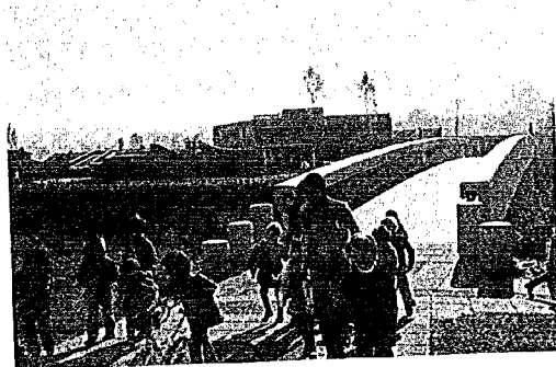
写真-4.6 リヨン近郊の新都市 リール・ダボー 車道の横断はすべて立体横断施設で行う歩行 者道路網が完備しており、車道側端に歩道は設 置されていない。一戸建住宅の街区では、袋小 路 (キュ・ド・サック : Cul de sac) 方式 なども採用されている。。
