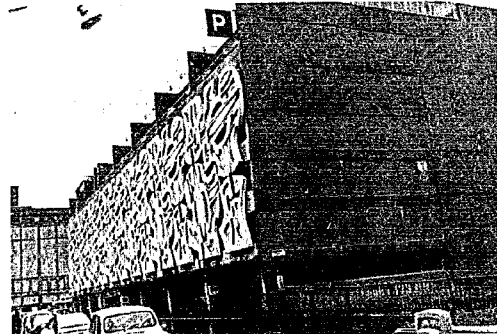
写真-3.13 ルーアンの駐車場 都心部歩行者区域の近傍、バスターミナルの横に設置されている多層駐車場
