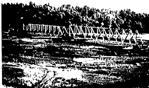
1975年の火山泥流によって破壊された鉄道橋
