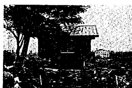
写真-8 第一氾濫区間のほぼ中央に位置する家屋で、鉄筋コンクリートの基礎の高い家では、被害が一部損傷
