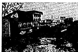
写真-7 第一氾濫区間上流端の流の停止状況
