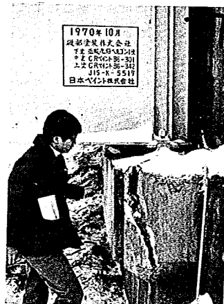
写真4.3-2 錦桜橋右岸橋台のコンクリート 剝離〔国道346号線〕
