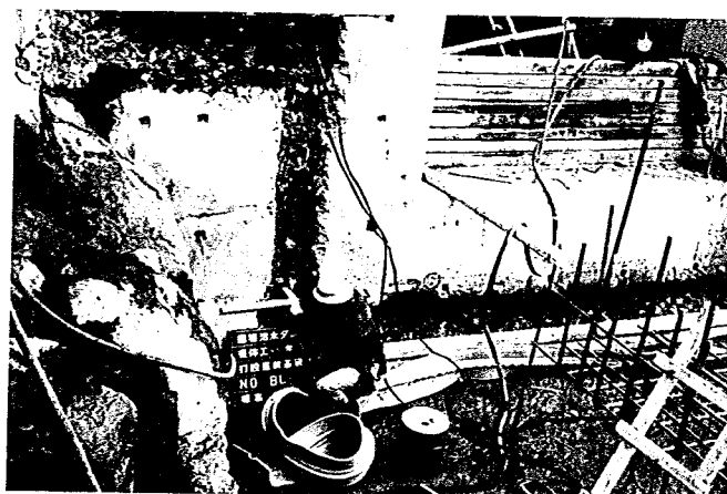
フィレット取付部 止水工用既設コンクリートの のはつり
