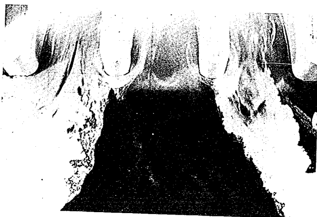
写真-24 越流部の流況 (貯水位 EL 172)
