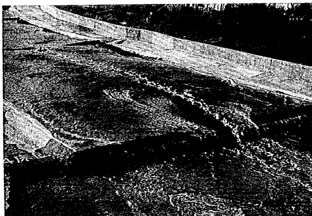
ケース12 流量 800\text{m}^3/\text{s} 第4床固工右岸袖部越水状況
