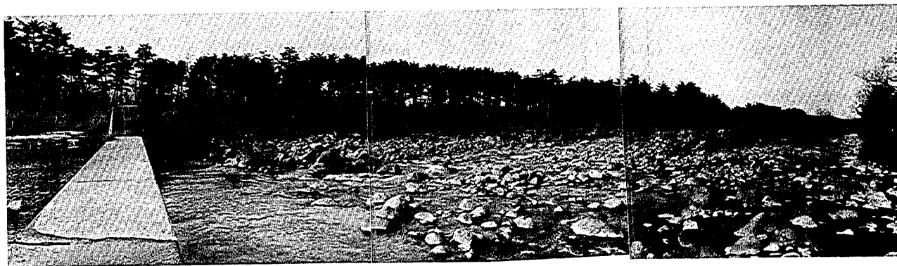
写真 2 荒川第10床固とその下流の河状
