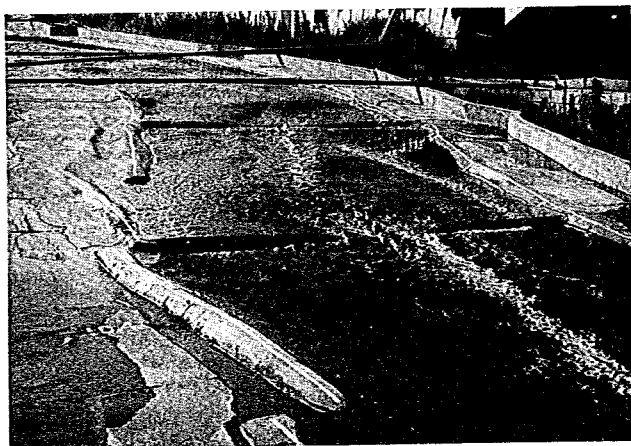
ケース 12 流量 1,100\text{m}^3/\text{s} 第10, 第2, 第5床固工 袖部越流状況
