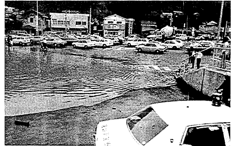
写真-12 配水管の破損により浸水した国道 286 号 (仙台市向山 4 丁目)
