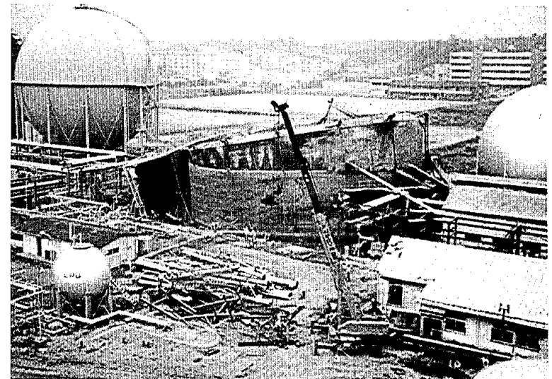
写真-14 炎焼したガスホルダー (仙台ガス原町工場)
