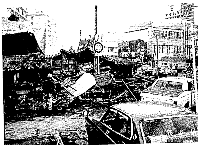
写真-3 木造家屋の被害(仙台市長町)
