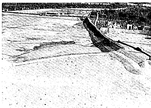
左岸堤防の引堤状況
