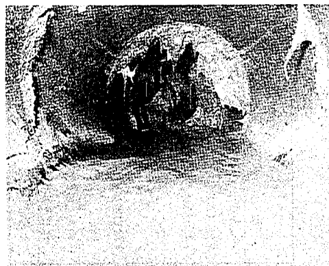
写3 Murray Runの管渠内に侵入した木の根
