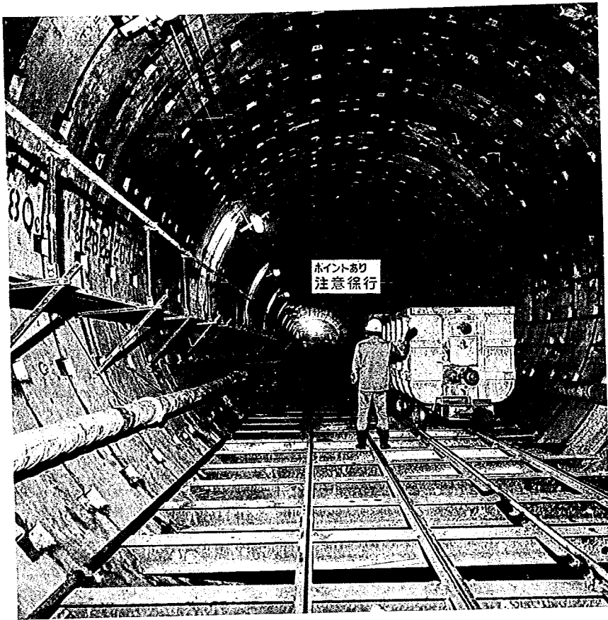
工事中の天王寺ー弁天幹線
