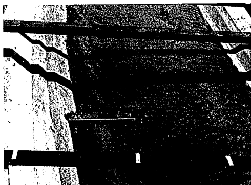
写真-30 0.6km落差工 <ほとんど土砂で埋没し、効果がない>
