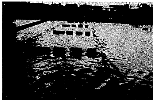
写真- 2.6 計画橋橋脚のせき上げ
