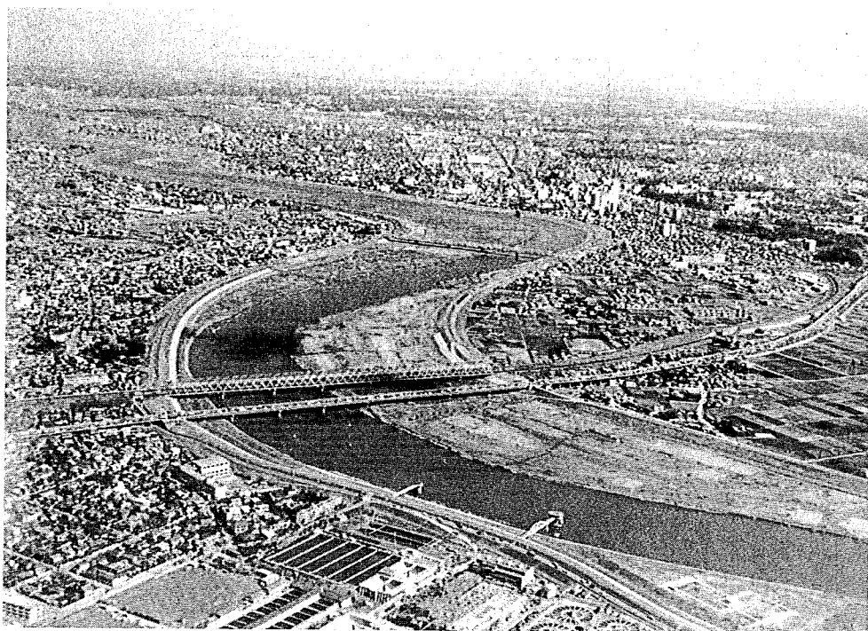
写真一 1.1 江戸川渡河地点付近空中斜写真
