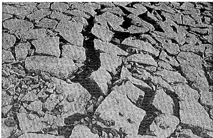
図-13 牛野ダム上流面の きれつ(その1) 巻末にカラー写真あり(以下 同じ)
