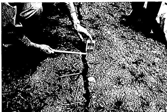
図-16 蒜但木 ダム天端きれつ (その2)
