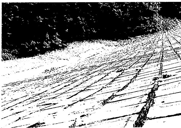
図一 2 5 川原子ダム法面（その 2）
