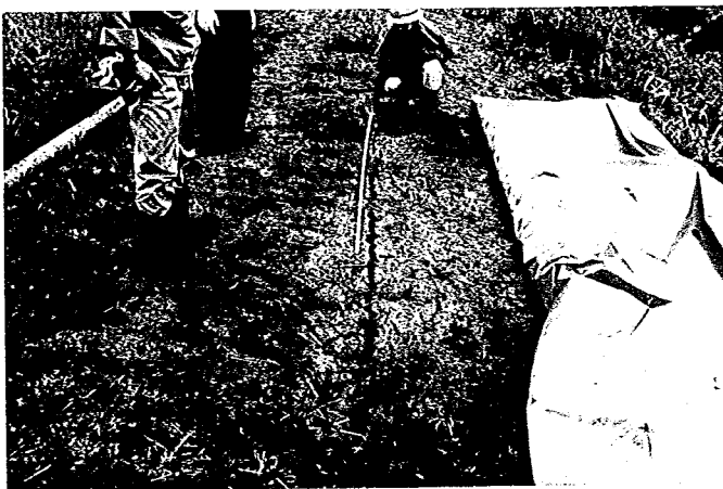
図-16 蒜但木ダム天端きれつ (その1)
