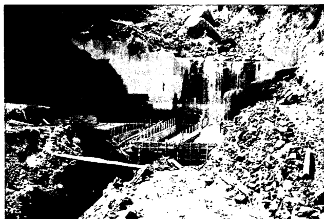
土石流による袖部破損，下流洗掘
