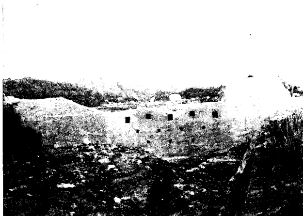
3号ダム被災状況（正面）
