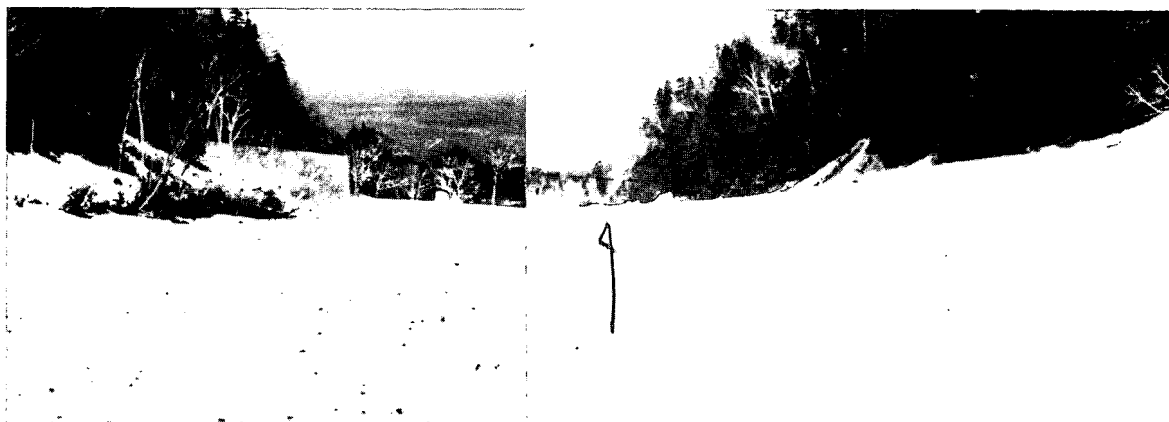
ダム被災後 上流より
