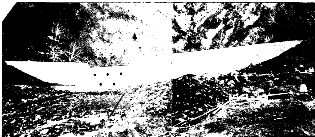
被災前ダム全影 水道巾 15.0 m
