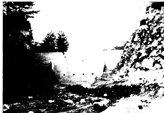
2号ダム被災状況（正面）
