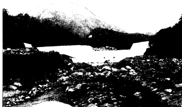
4号ダム被災復旧後（正面）
