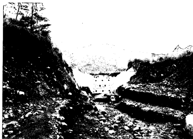
6号ダム被災状況（正面）
