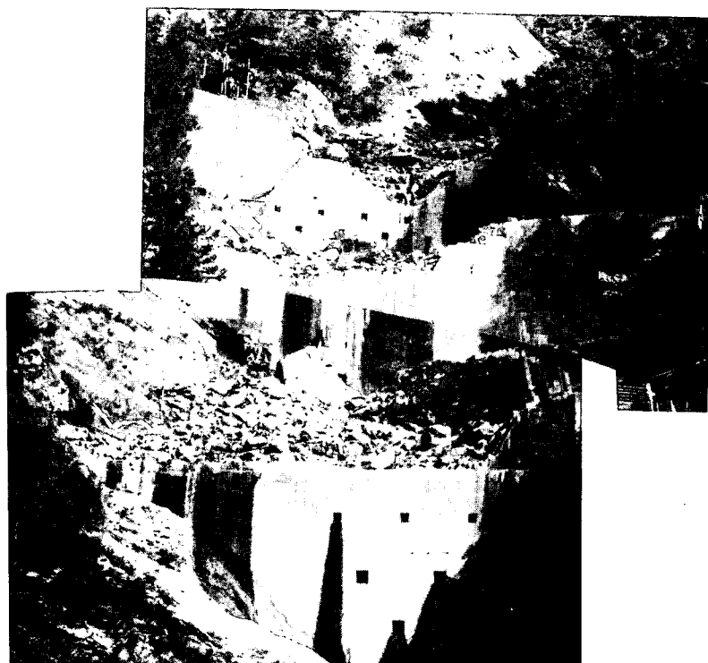
土石流による袖および天端破損
