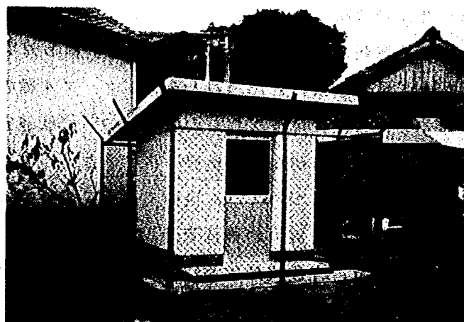
写真－4 地盤の強震観測小屋（御前崎）
